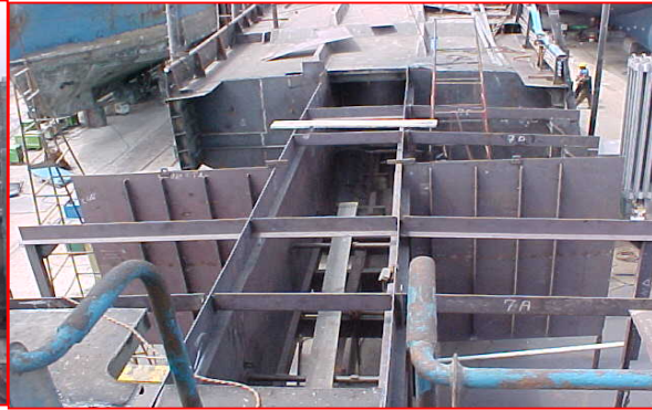
ERECCION DE CUADERNAS DE MODULOS
