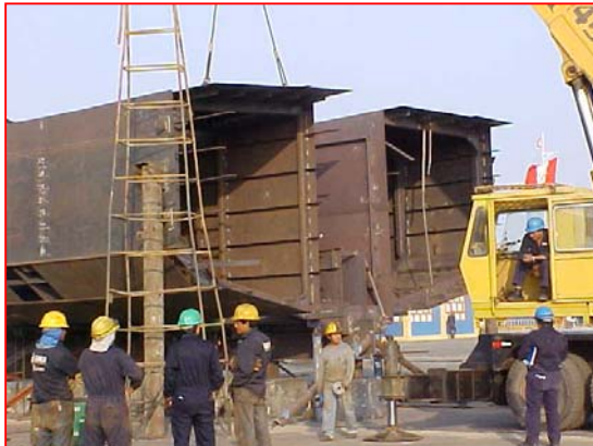
ERECCION MODULOS BODEGAS ESTRIBOR
