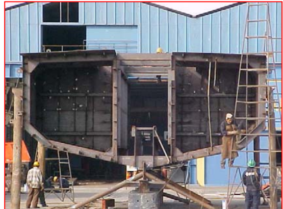
ENSAMBLE COMPACTO MODULO DE BODEGAS
