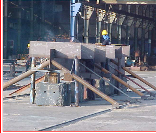
INSTALACION DE QUILLA Y VARENGAS CENTRALES
