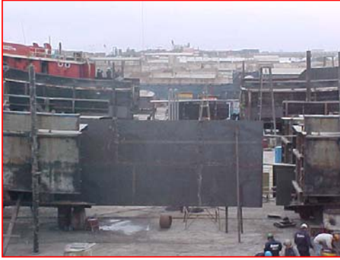
CORTE DE ESLORA Y ENSAMBLE DE MAMPARO LONGITUDINAL
